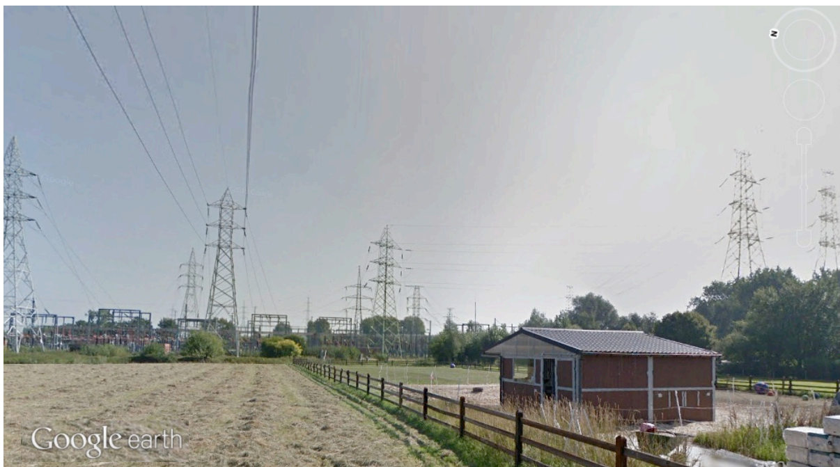
Fig. 6. Google Earth Street View opname van de paardenstal en het achterliggende hoogspanningsstation. (© 2019 Google / © 2009 GeoBasis-DE/BKG)
